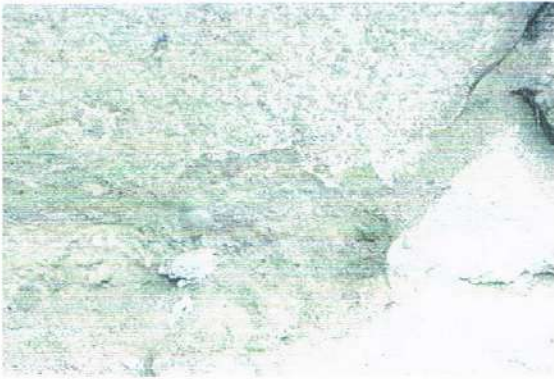
الصورة رقم 9: فقدان ترابط الحبيبات
